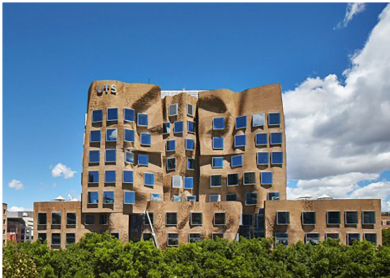
Fig.3. Nuova sede della Business School della University of Technology (UTS) di Sydney 2014, progettata da Frank O. Gehry. La costruzione è costata appena 150 milioni di dollari, denominata “ Dr Chau Chak Wing Building ”, dal nome del suo principale finanziatore, il magnate australiano-cinese Chau Chak Wing. Costruita in pietra arenaria e vetro all'esterno e di legno e acciaio all'interno, oggi non permette nessuna modica, nessun adeguamento, nessun miglioramento alle condizioni climatiche e alle differenti esigenze degli studenti.
