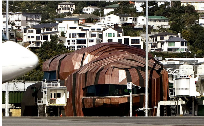
Fig.1. Wellington International Airport, New Zealand. The Rock 2010. Studio Pacific Architecture. Rivestita completamente in acciaio corten, questa realizzazione esercita delle temperature interne insopportabili per gli utenti in transito.
